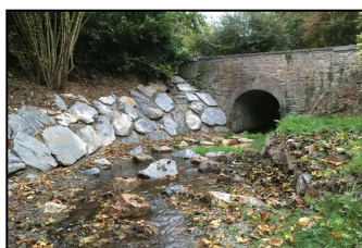
Recharge du lit, protection de berges, création d'une rampe rustique en aval du Pont de la Crépellière à Montigné le Brillant.
